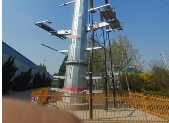
图6-4 电缆终端塔
