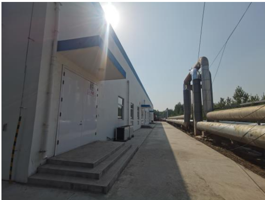
图6-5 站内地面硬化
