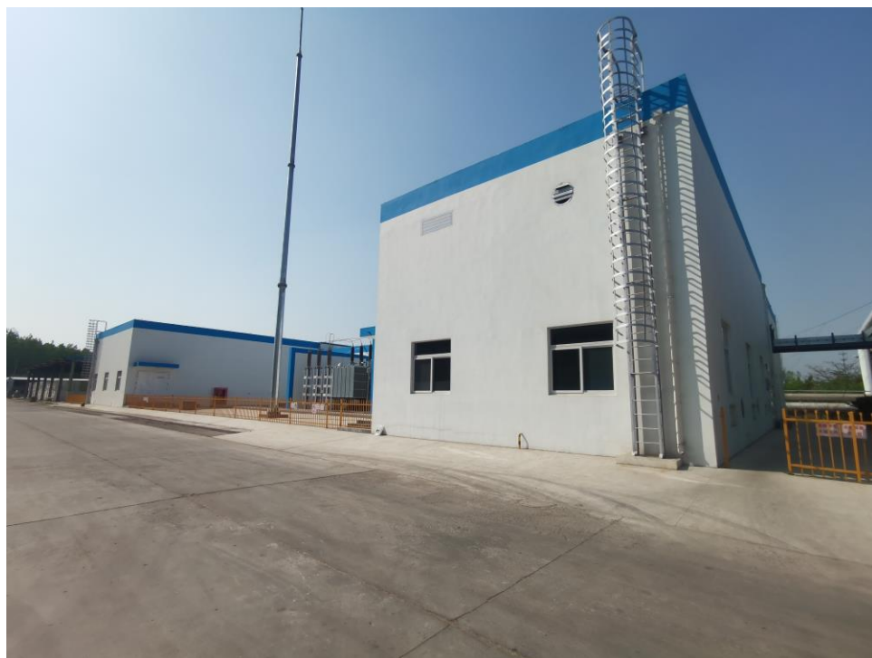
110kV 华泰纸业变电站
