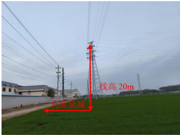
图 7-3 110kV 乐南线、110kV 军泰线双回架空线路衰减
