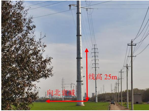
图 7-1 四回架空输电线路衰减
