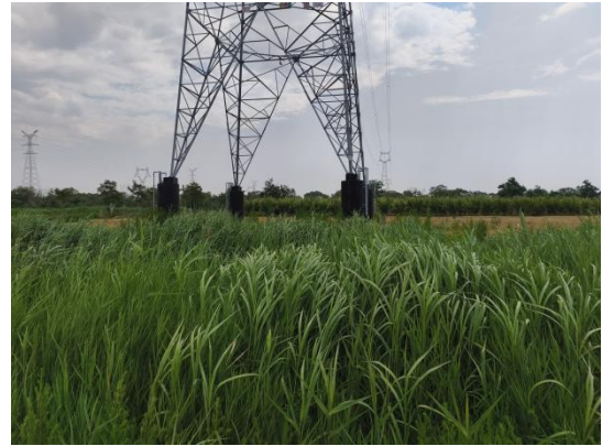
图6-4 黄河口国家公园内塔基周围恢复情况1
