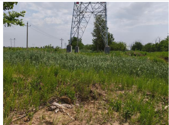
图6-6 黄河口国家公园内塔基周围恢复情况3
