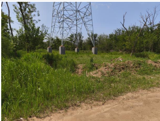
图6-5 黄河口国家公园内塔基周围恢复情况2
