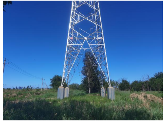
图6-2 塔基周围恢复情况2
