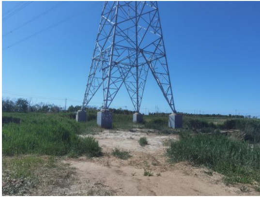
图6-1 塔基周围恢复情况1
