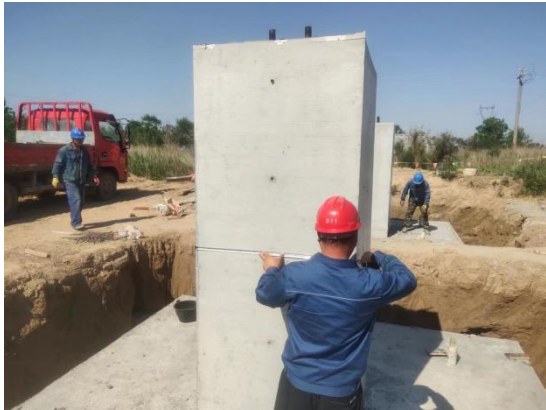
图6-7 施工时按照设计开挖,未破坏周围植被
