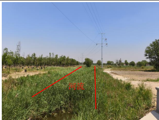
图6-6 跨越河流情况（未在河中立塔）
