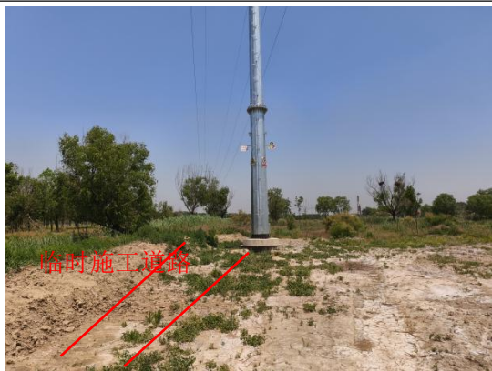
图6-5 临时施工道路恢复情况
