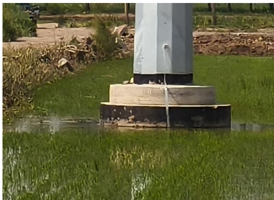
图6-2 新建塔基周围恢复情况2
