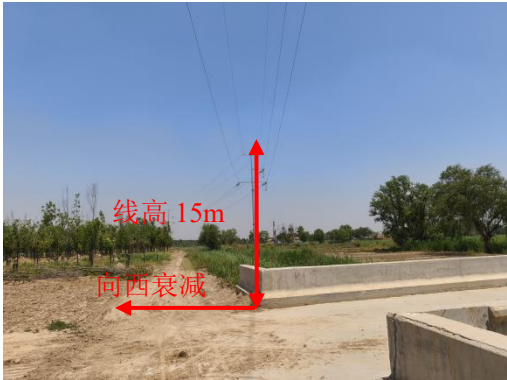
图 7-3 110kV 史梁线 16T 线单回架空衰减
