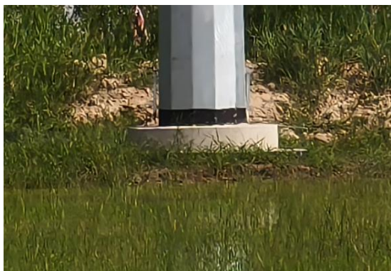
图6-1 新建塔基周围恢复情况1
