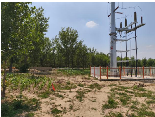
图6-3 新建塔基周围恢复情况3
